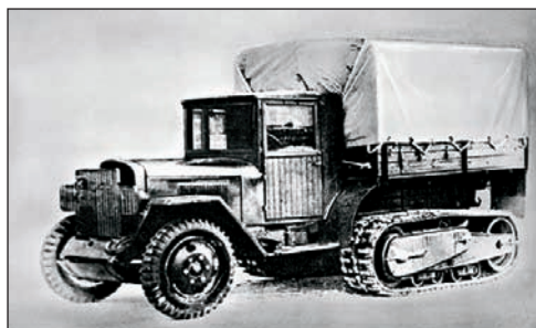
Рис. 1.11. Автомобиль ЗИС-42 с колесно-гусеничным движителем
